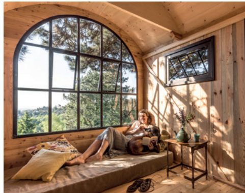
Das frontseitig eingebaute, halbrunde Stahlrahmenfenster stellt neben zwei anderen ein zentrales Gestaltungselement dar. Es wurde liebevoll restauriert und erhielt zwei Flügel vom Schlosser.
